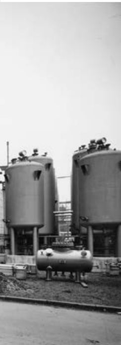
Kunststoff-Technikum 1967 mit der im Bau befindlichen TCD-Alkohol DM-Anlage
