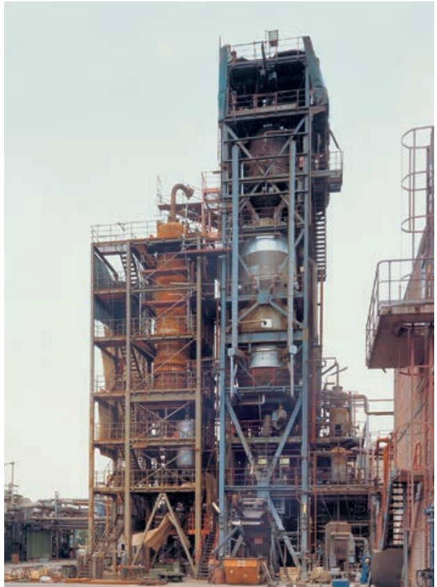
Reaktorbereich Versuchs- anlage Kohlestaubvergasung, RCH/RAG 1978
