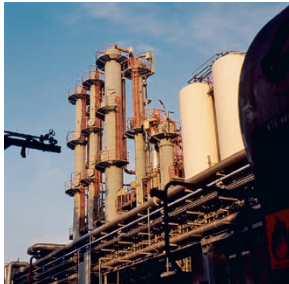
Teilansicht der Aminanlage, 1988
